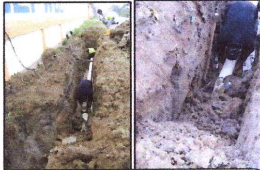
AMPLIACIÓN DE 60 M DE RED TERCIARIA CON TUBERÍA DE 215MM EN CDLA. LA FAMILIA, SECTOR COLEGIO WENSCELAO OLLAGUE Y AV. SANTA ROSA Y 14TA.
