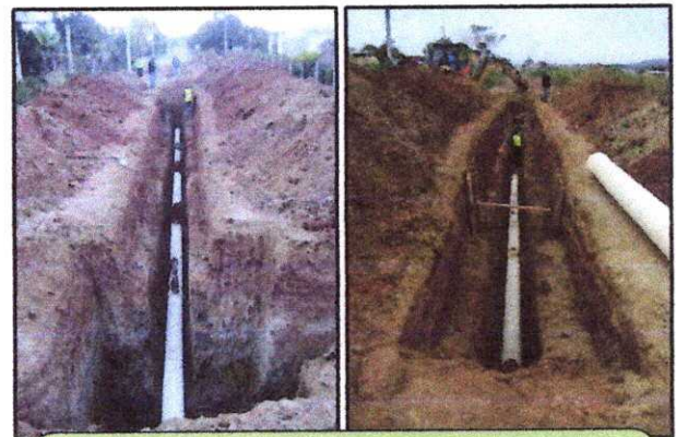
AMPLIACIÓN DE 130 m RED PRINCIPAL DE ALCANTARILLADO CON TUBERÍA DE 315 mm EN CDLA. VITE CORONEL
