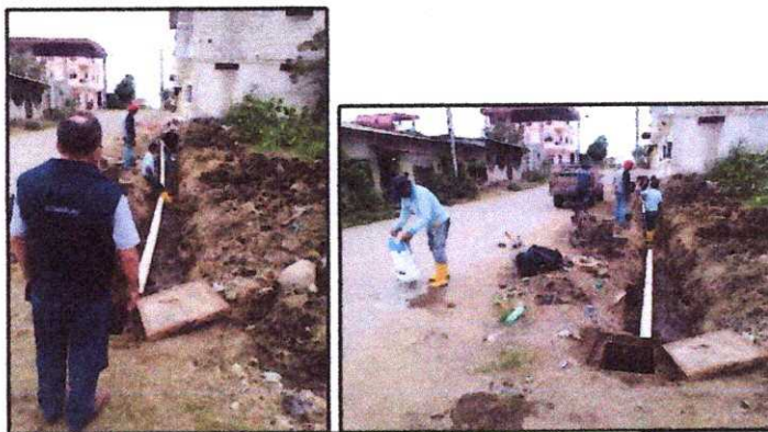
AMPLIACIÓN DE 50M DE RED TERCIARIA CON TUBERÍA DE 175mm EN CALLE ZOILA ARÁUZ - BARRIO TENIENTE HUGO ORTIZ
