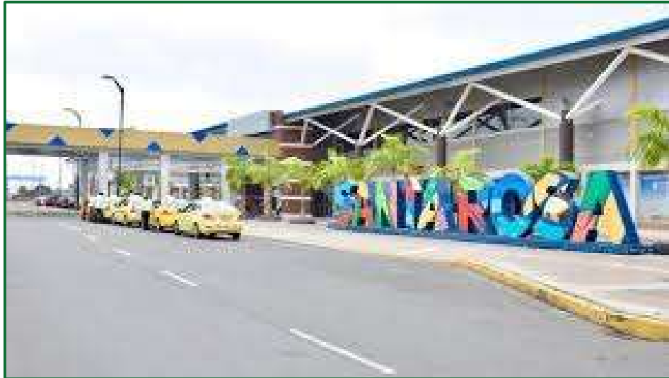
Ilustración 112: Terminal Terrestre Binacional Santa Rosa.
