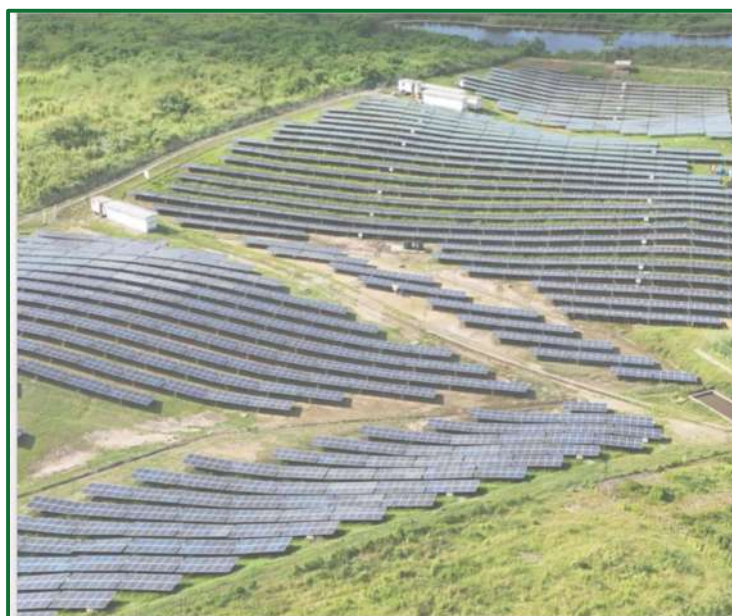
Ilustración 105: Parque Solar San Antonio (3 MW)
